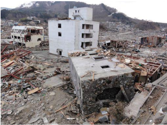
図1. 転倒したコンクリート造建物
