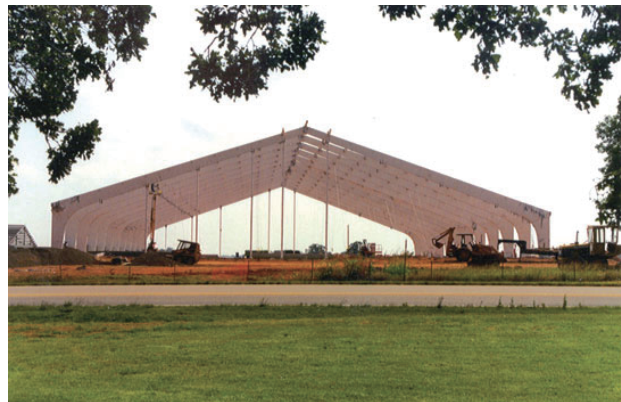
(b) 3ヒンジラーメン構造
