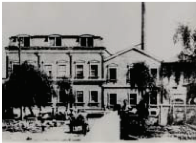
図 1.3 秀英舎印刷（現在の大日本印刷）工場（地上 3 階、地下 1 階基準階 52.5 坪。鉄材はフランスで購入、1894 年竣工、1910 年火災で全焼）
