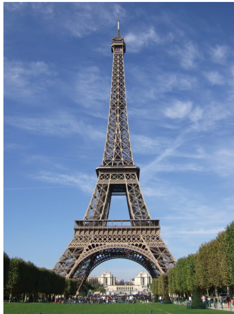
図 1.2 エッフェル塔 (Pari, France, 1889 年建設、1991 年に世界遺産。展望台は 3 つ：高さは 57.6m、115.7m、276.1m。)
