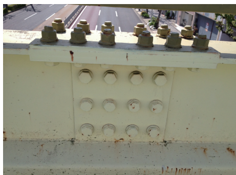
図 8.2 高力ボルト接合（名市大北千種キャンパスの外にある歩行橋）
