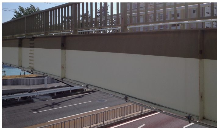
図 6.2 均等間隔の横補剛（名市大北千種キャンパスの外にある歩道橋）
