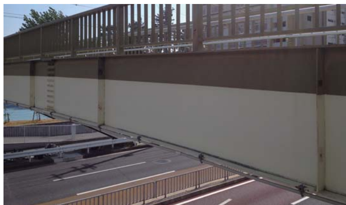
図 6.2 均等間隔の横補剛（名市大北千種キャンパスの外にある歩道橋）
